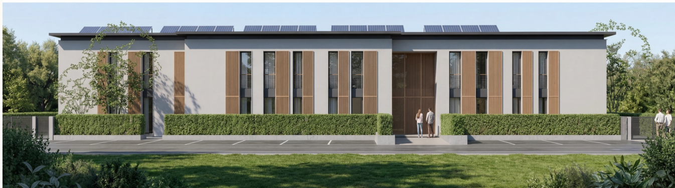
FRONTE GIARDINO (SUD) · FRONTE STRADA (NORD) — PANNELLI FOTOVOLTAICI IN COPERTURA
